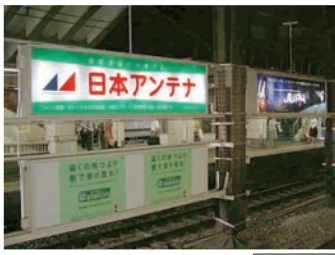
整備前 横長の電額ばかりでバリエーションがなく老朽化していた。
